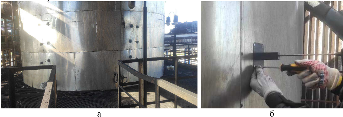
Рис. 10. Смонтированная система (а) и монтаж модуля системы СОМТ-01 (б)
