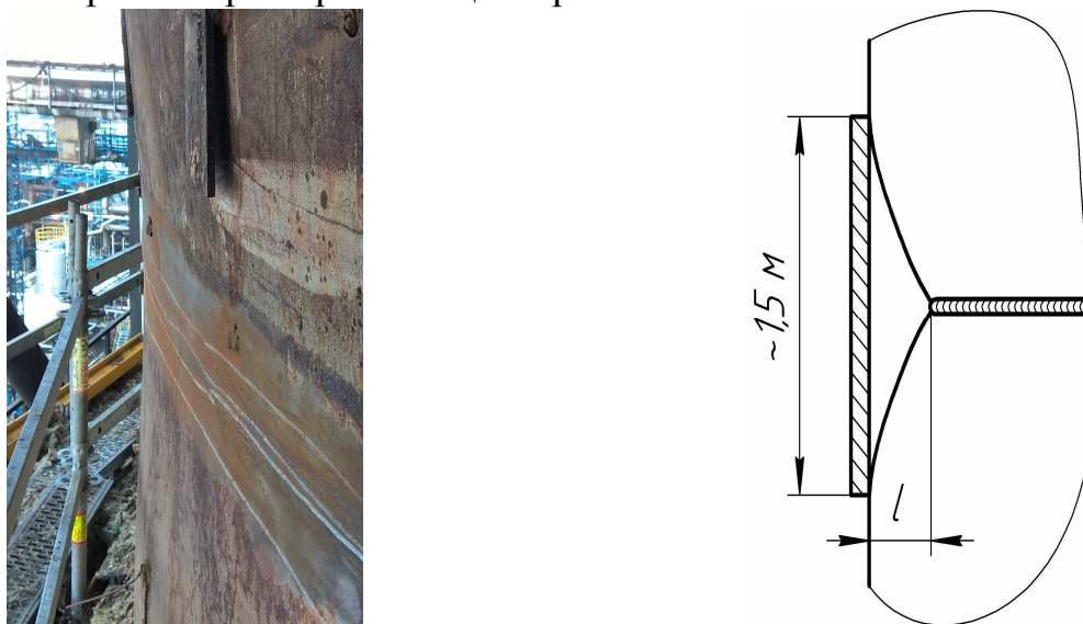
Рис. 2. Общий вид деформации в районе кольцевых швов (слева) и схема проведения замера прогиба гофров l (справа)
