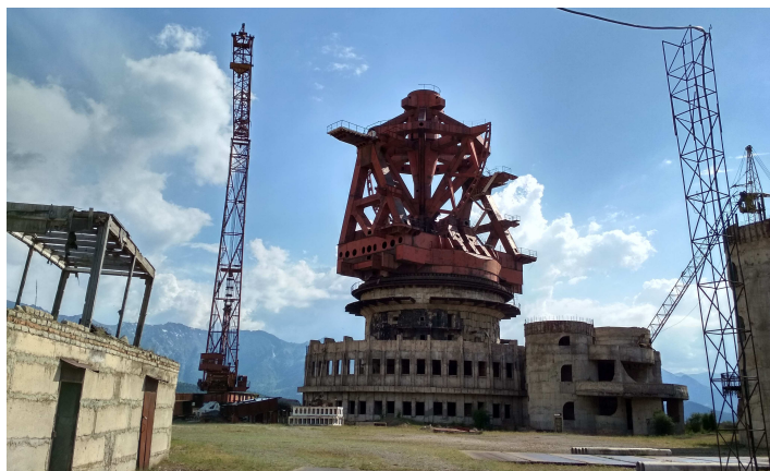
Рис. 1. Строящийся радиотелескоп на договора между Россией и Узбекистаном
